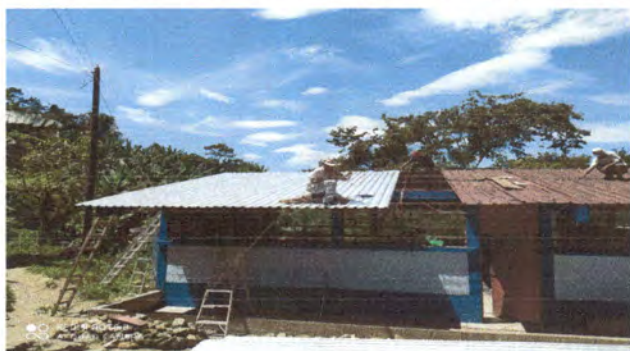
Foto 3: Sustitución de lamina modulo 1
