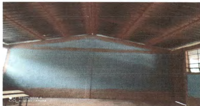
Foto 4: Mantenimiento a estructura metalica (Pintura a costaneras)
