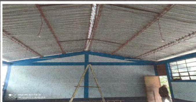
Foto 5: Distribucion de cableado electrico
