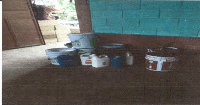
Foto 6: colocación de pintura muros interiores y exteriores
