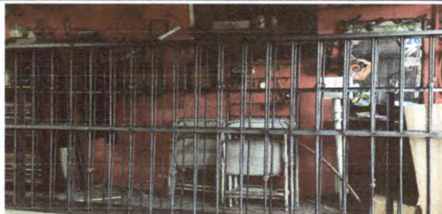
Foto1: Realización de balcones
